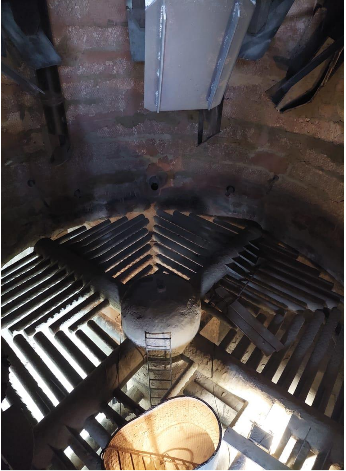
ŞƏKİL.2.5. Heydər Əliyev adına Neft Emalı Zavodunda reaktor regenator qurgusunun torkert beton olan real görüntüsü
