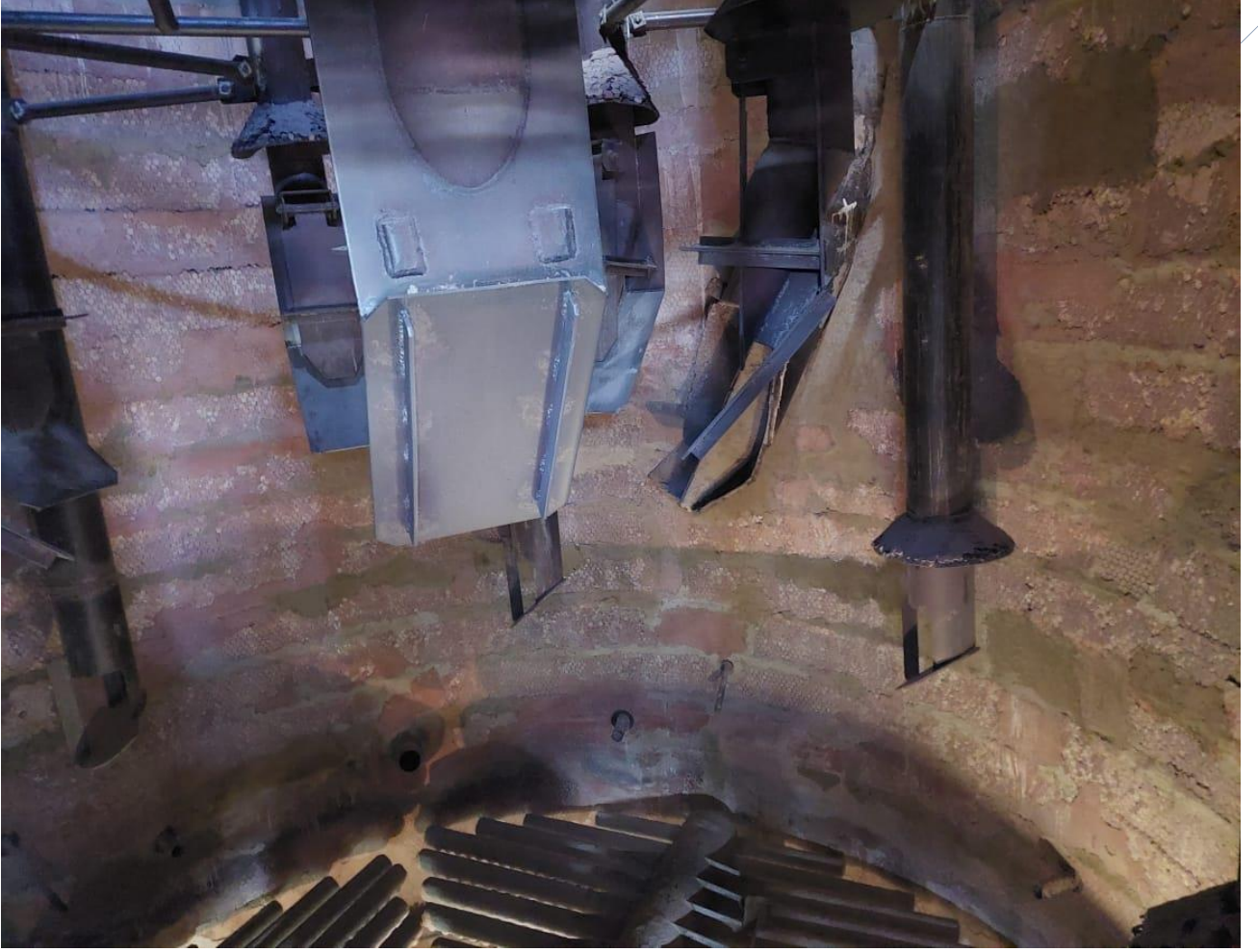
ŞƏKİL2.6. Heydər Əliyev adına Neft Emalı Zavodunda reaktor regenator qurgusunun torkert beton olan real görüntüsü
